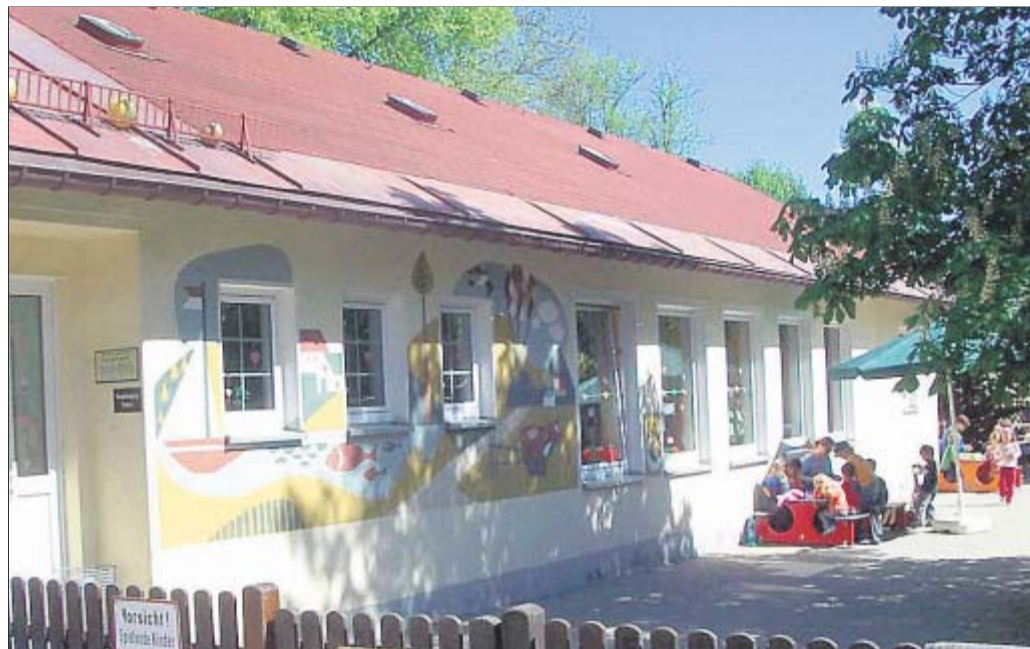
Mit einem Kostenaufwand von 150 000 Euro werden im Kindergarten der Gemeindefriede Krippenplätze eingerichtet. FOTO: BUSSLER
